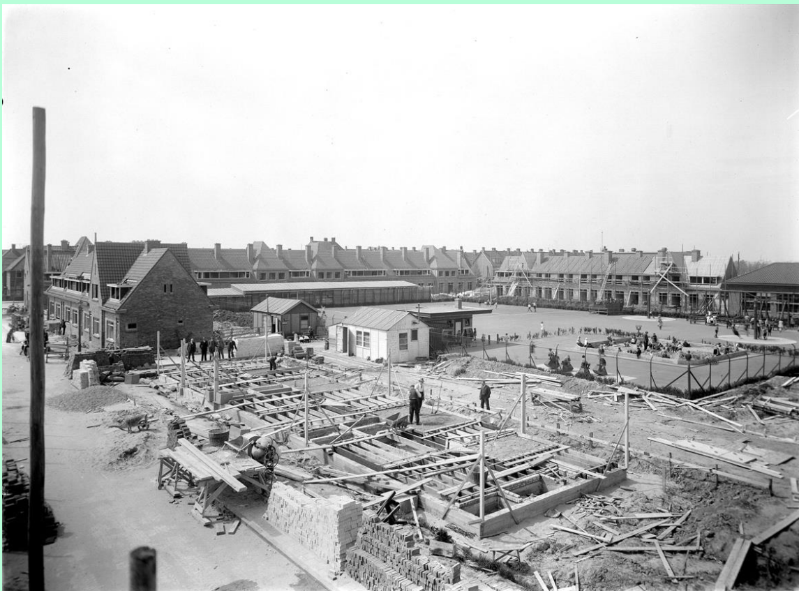
4. Ambonstraat noordzijde in aanbouw met daarachter het speelterrein "Oosterkwartier", vanaf de Sumatrastraat naar het noordwesten gezien. Op de achtergrond in het midden huizen aan de Driftstraat en rechts de Atjehstraat (ca. 1934)
